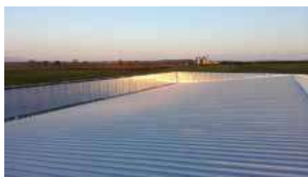
› Vista esterna copertura sistema DELTA
