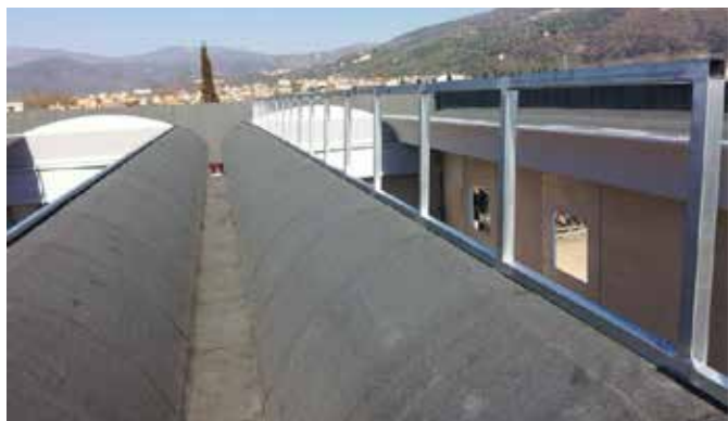
» Impermeabilizzazione e Coibentazione Elementi "PRISMA"
