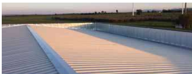
› Particolare colmo esterno copertura sistema DELTA
