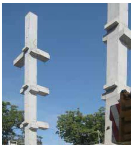
» Pilastrini Pluripiani con Mensole e Sbalzi.
