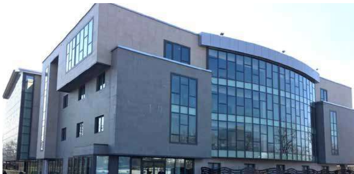
» Vista d'insieme struttura completata.
