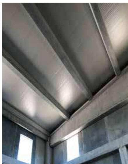
› Vista interna copertura sistema DELTA
