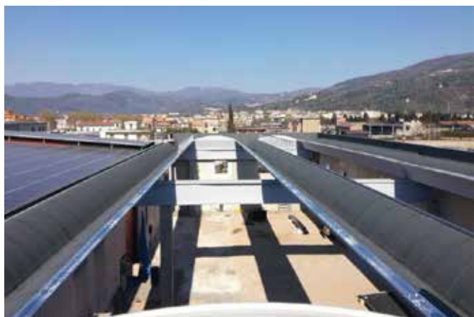
» Impermeabilizzazione e Coibentazione Elementi "PRISMA"
