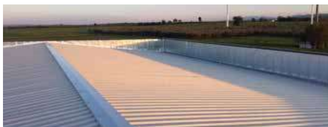
› Particolare colmo esterno copertura sistema DELTA
