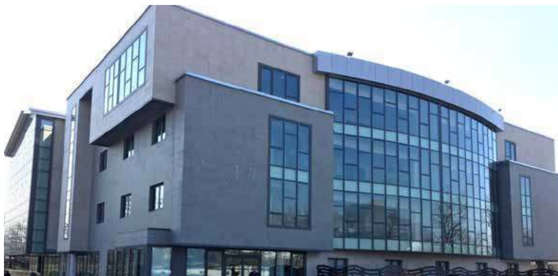
» Vista d'insieme struttura completata.
