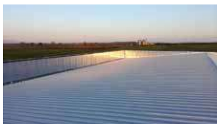
› Vista esterna copertura sistema DELTA
