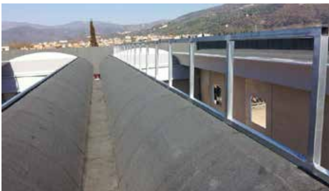
» Impermeabilizzazione e Coibentazione Elementi "PRISMA"
