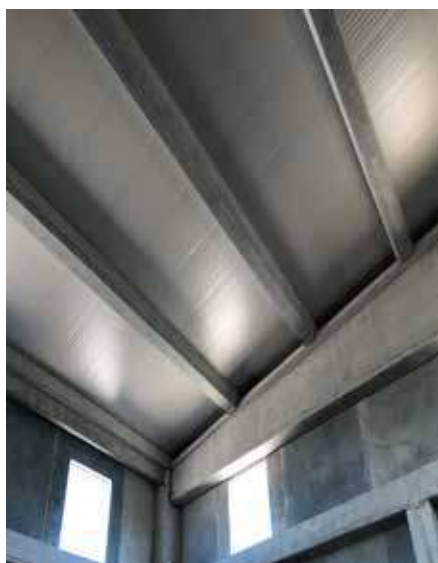
› Vista interna copertura sistema DELTA
