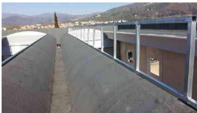
» Impermeabilizzazione e Coibentazione Elementi "PRISMA"
