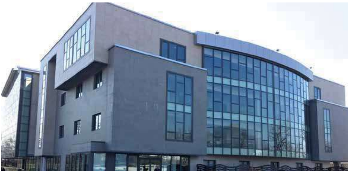
» Vista d'insieme struttura completata.
