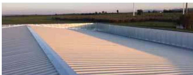
› Particolare colmo esterno copertura sistema DELTA
