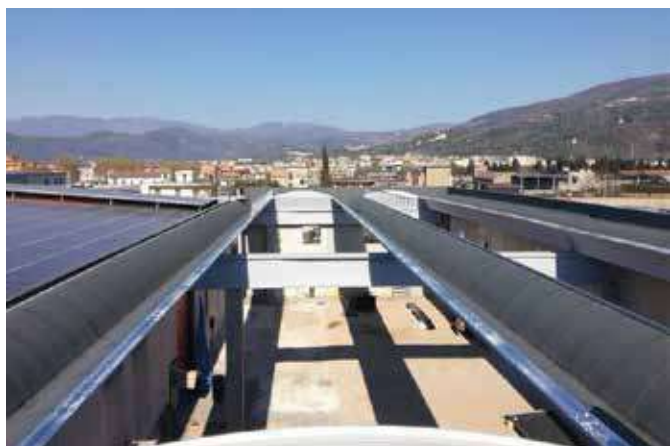
» Impermeabilizzazione e Coibentazione Elementi "PRISMA"
