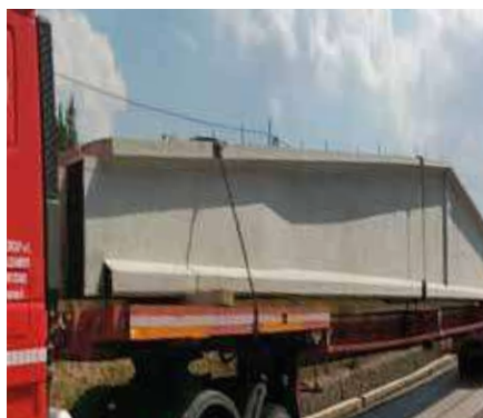
› Particolare dell'appoggio dell'elemento DELTA su capriata. › Trasporto Capriata per Sistema DELTA.
