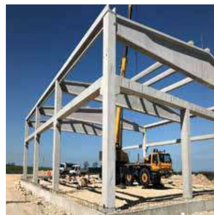
› Particolare della Trave-Gronda Sistema DELTA
