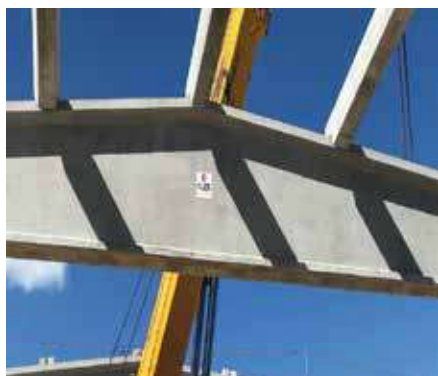
› Particolare dell'appoggio dell'elemento DELTA su capriata. › Trasporto Capriata per Sistema DELTA.
