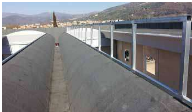
» Impermeabilizzazione e Coibentazione Elementi "PRISMA"
