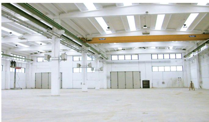
Sistema identificativo di una tradizione decennale della prefabbricazione del Nord Italia, la trave doppia pendenza rimane ad oggi la soluzione ottimale per numero-se tipologie di edificio.
