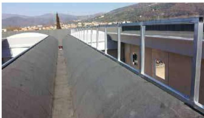
» Impermeabilizzazione e Coibentazione Elementi "PRISMA"
