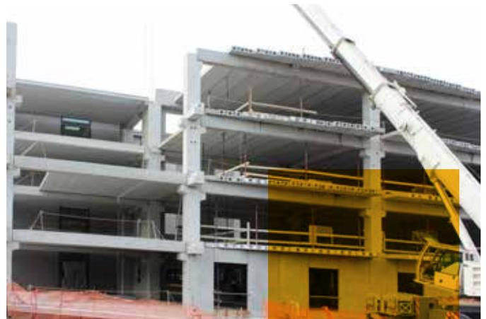
Kypse può sopportare carichi da 200 a 5200 kg/mq. La sua composizione in cemento armato precompresso assicura a progettisti ed imprese un'ottima trasmissione di sforzi nel piano e bassi valori di deformabilità per flessione.
