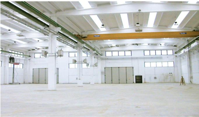
Un système qui identifie une tradition de préfabrication de plusieurs décennies dans le nord de l'Italie, la poutre à double pente reste à ce jour la solution optimale pour de nombreux types de bâtiments.
