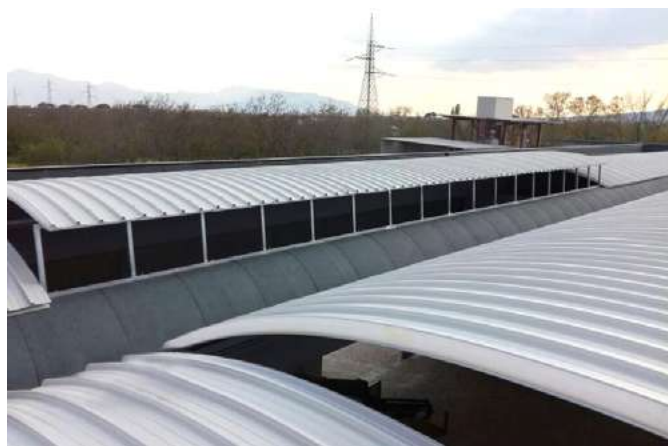
» Couverture entre les éléments « PRISMA » avec panneau sandwich - Vue extérieure
