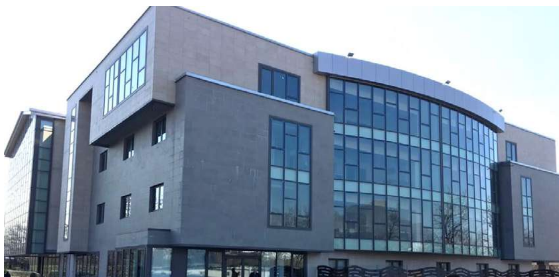
» Vue d'ensemble de la structure achevée.
