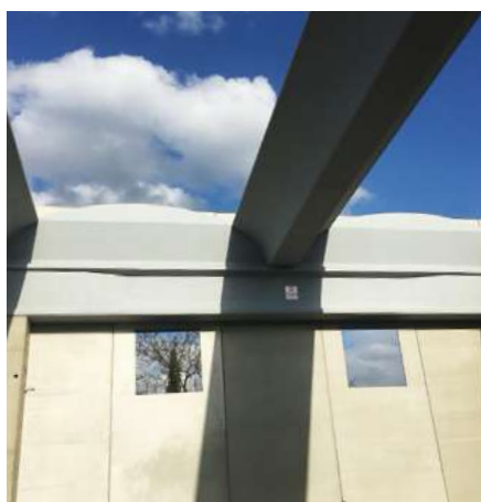
» Support « PRISMA » sur la poutre latérale « ADI ».
