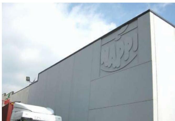
» Panneaux verticaux et horizontaux gris ciment
