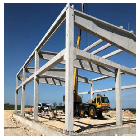
» Détail du système DELTA de poutre et d'avant-toit
